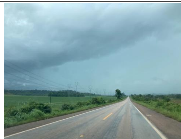
Foto 94: 3 linhas de transmissão paralelas de 500 kV da UHE Jirau para a subestação de Porto Velho ao longo da rodovia BR-364
