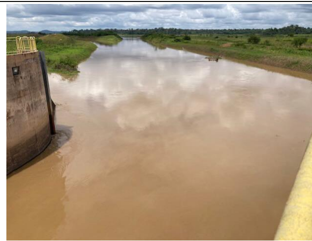
Foto 37: Canal de aproximação a montante do vertedouro de troncos
