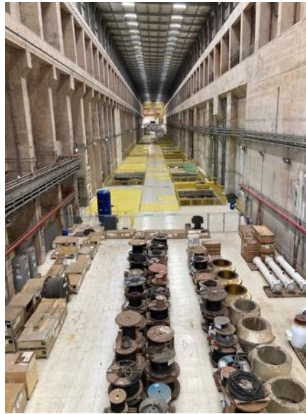
Foto 50: Vista da casa de força da margem esquerda
