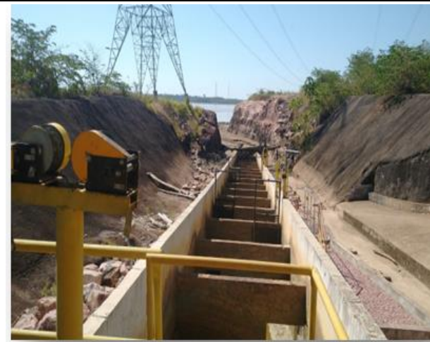
Foto 36: Canal de aproximação de uma das duas instalações de passagem de peixes
