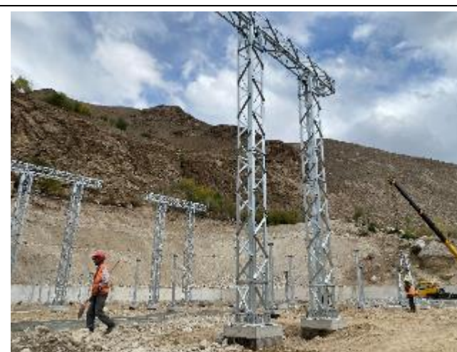
Фотография 84: Строящаяся Себзорская подстанция
