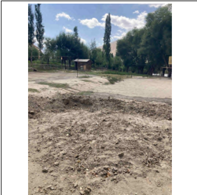
Фотография 31: Заполненная яма для разгонных испытаний на территории школы
