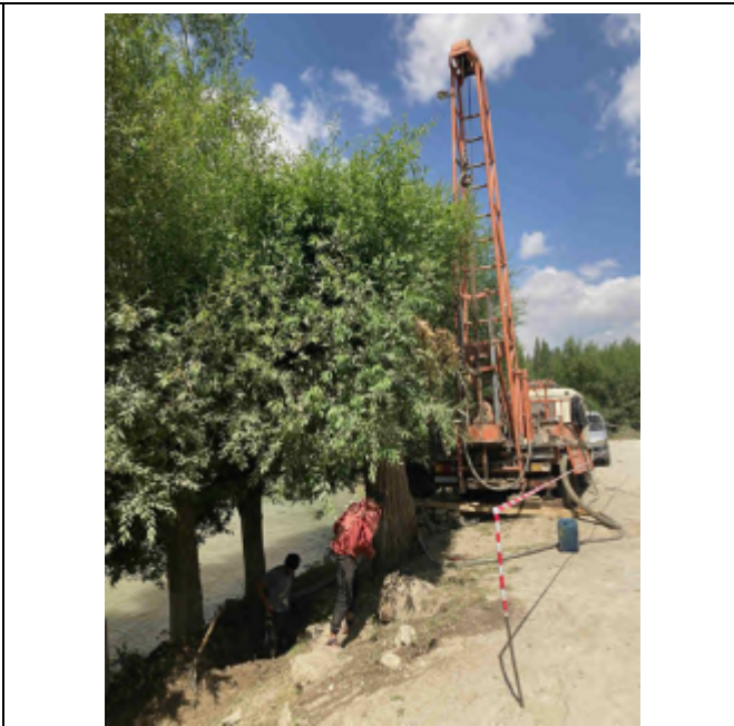
Фотография 32: Пробное бурение на мосту выше по течению от водозабора
