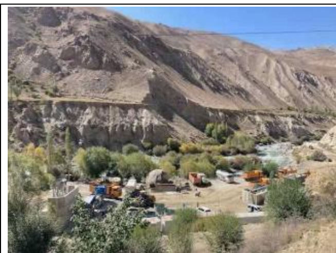
Фотография 82: Бетонный завод внизу от базового лагеря Себзорской ГЭС (административное здание)
