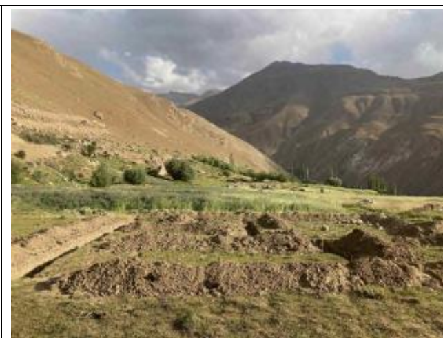
Фотография 69: Подготовка площадки для строительства нового дома в селе Верхний Чагев
