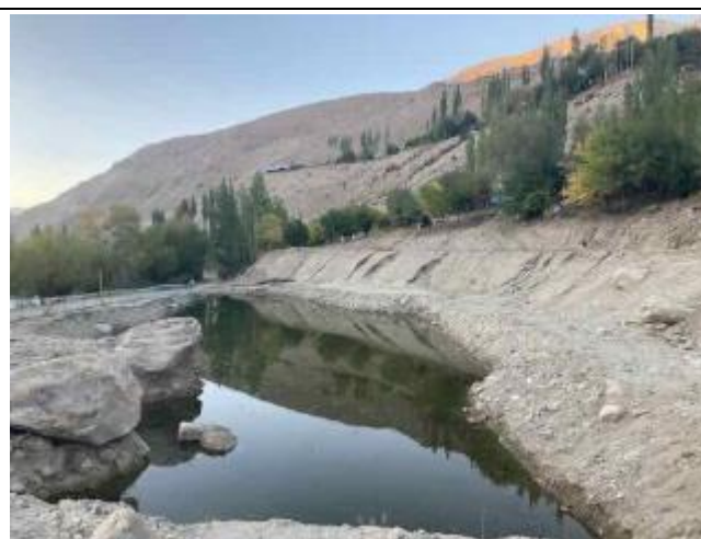
Фотография 83: Земляные работы на месте строительства машинного зала Себзорской ГЭС
