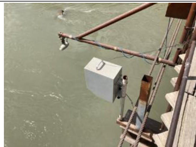
Фотография 28: Водомерное сооружение на старом мосту
