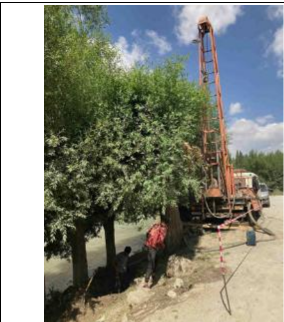
Фотография 32: Пробное бурение на мосту выше по течению от водозабора
