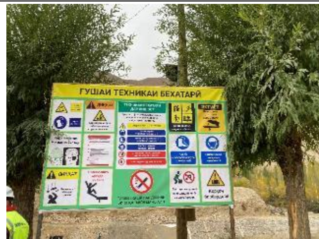
Фотография 88: Предупреждающие знаки на месте строительства водозабора
