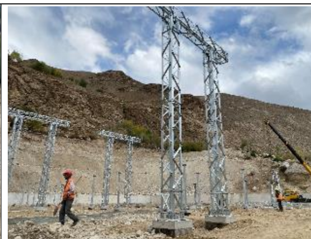
Фотография 84: Строящаяся Себзорская подстанция
