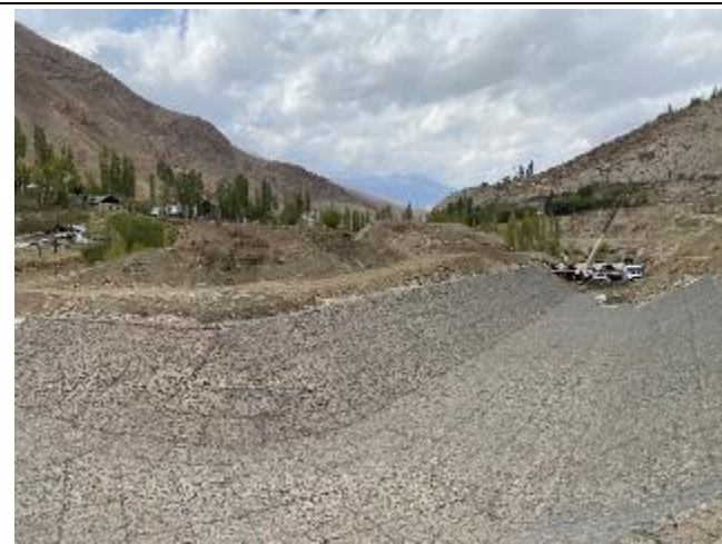
Фотография 85: Строящийся отводной канал для реки
