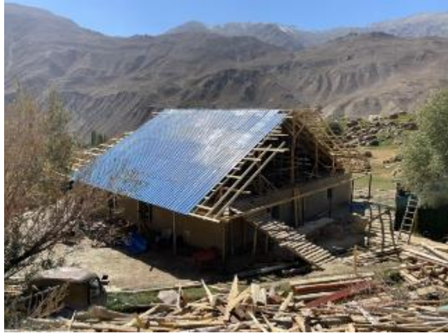
Фотография 118: Почти достроенный дом в селе Верхний Чагев
