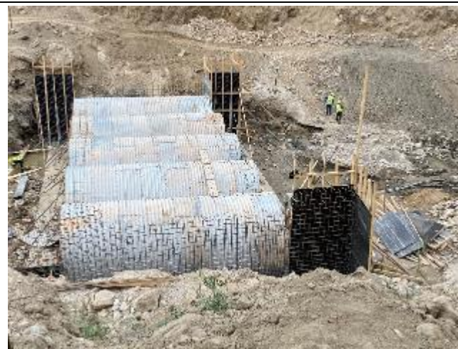
Фотография 86: Отводной канал реки со строящимся мостом
