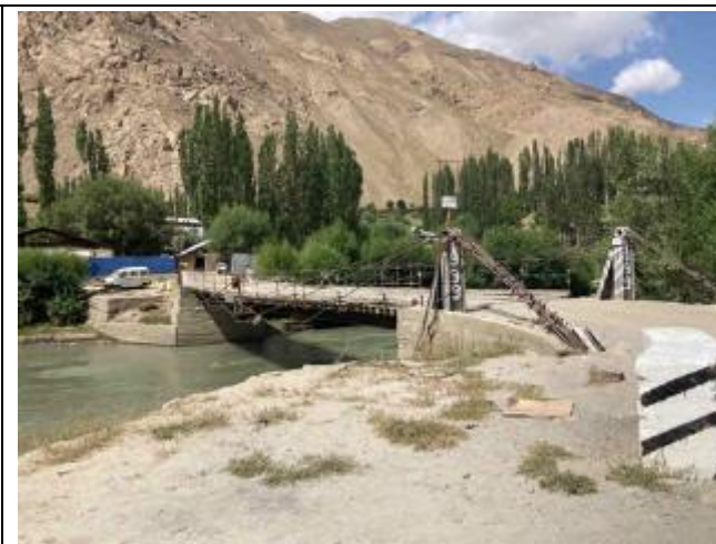
Фотография 27: Старый мост перед водозабором
