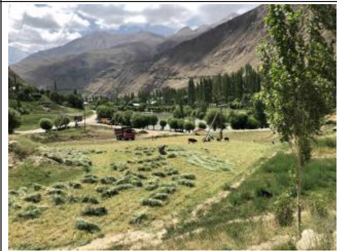
Фотография 36: Заготовка сена перед выемкой грунта на водозаборе
