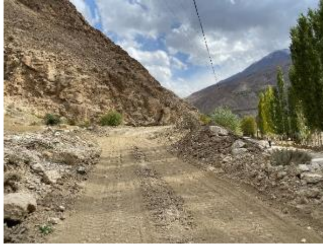
Фотография 119: Место временного складирования грунта и материалов
