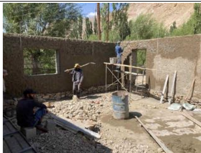
Фотография 23: Новый дом для семьи, переселенной из зоны затопления
