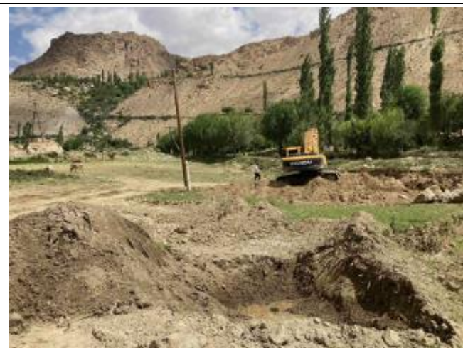
Фотография 49: Выемка верхнего слоя грунта на участке водозабора
