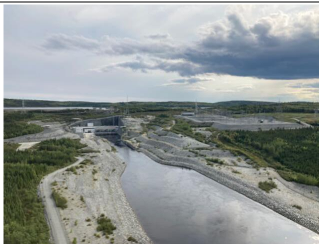
Photo 2 : Canal de fuite de la centrale de l'Eastmain-1
