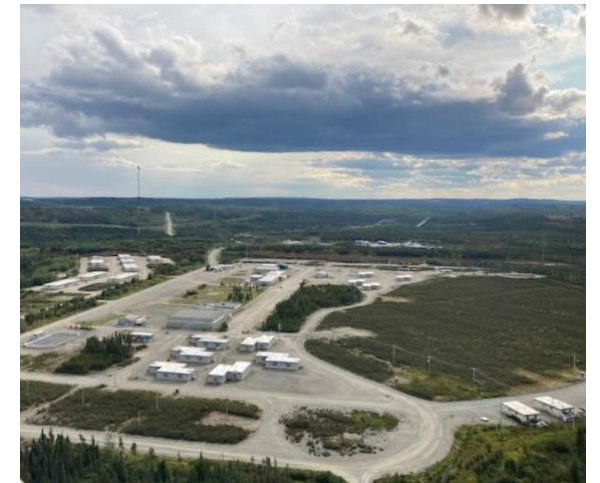
Photo 18 : Campement avec partie réhabilitée à droite
