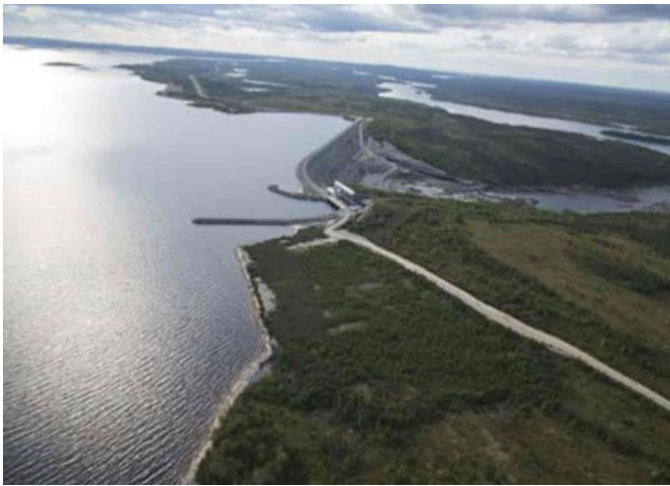
Photo 40 : Réservoir de la Paix des Braves, barrage et rivière en aval
