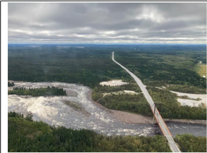
Photo 103 : Route de la Baie-James traversant la rivière Rupert
