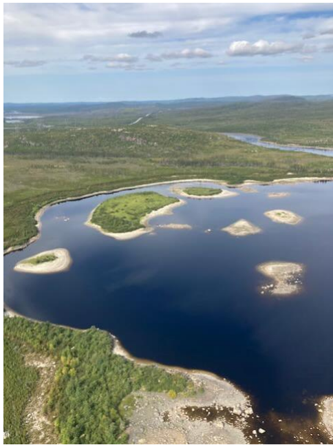
Photo 106 : Bief en aval du barrage de dérivation Rupert
