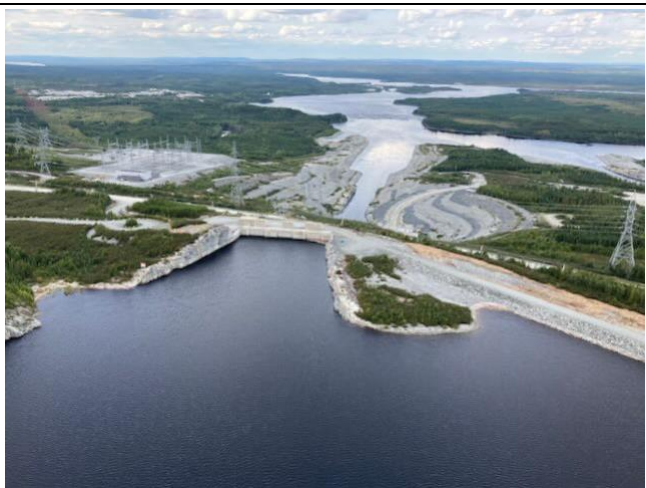
Photo 1 : Prise d'eau de la centrale de l'Eastmain-1
