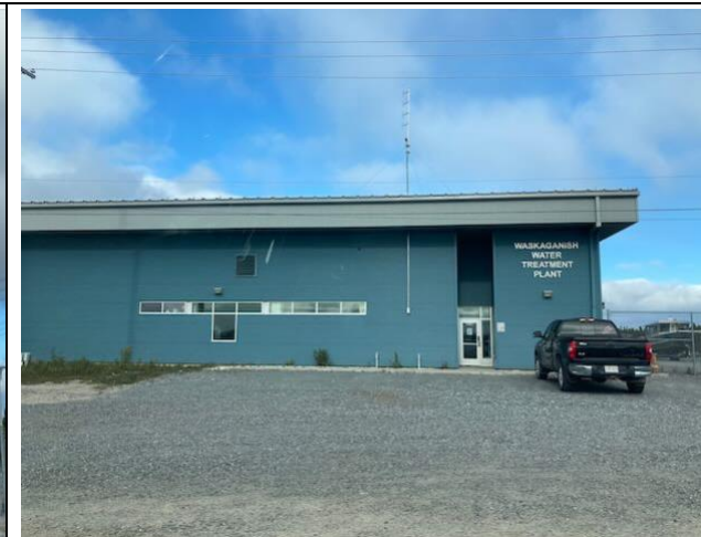
Photo 129 : Usine de traitement de l'eau potable financée par le projet
