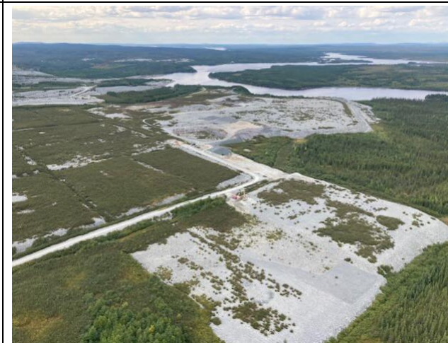
Photo 6 : Zones de travail partiellement revégétalisées à proximité de la centrale Bernard-Landry, vue vers la rivière Eastmain
