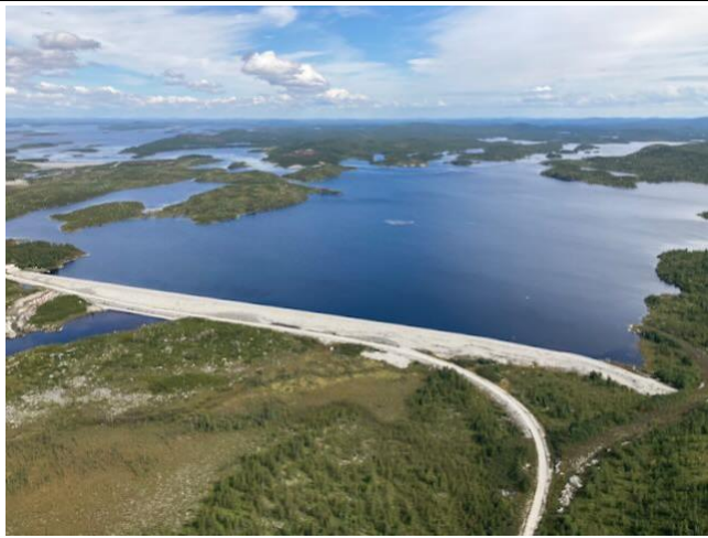
Photo 67 : Barrage et bief amont de la dérivation Rupert
