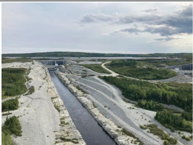
Photo 4 : Canal de fuite de la centrale de l'Eastmain-1a
