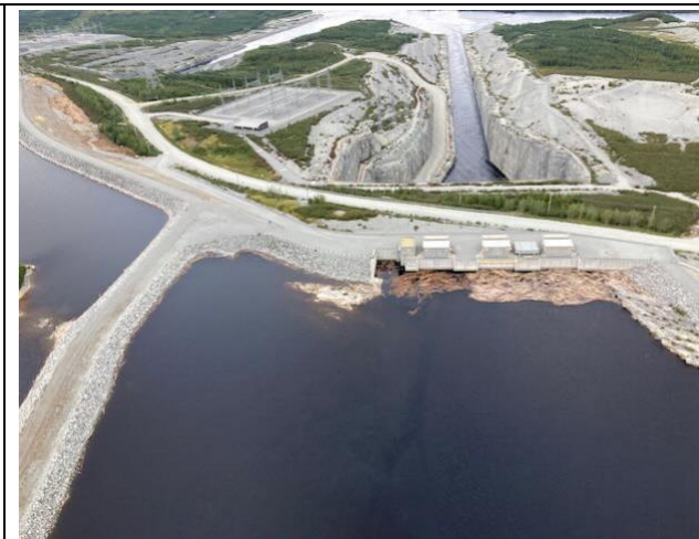
Photo 3 : Prise d'eau de la centrale Bernard-Landry avec rondins flottants
