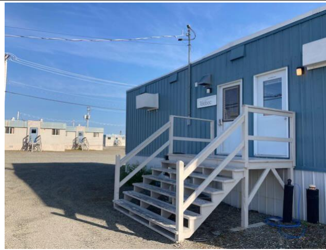
Photo 20 : Entrées de bureaux surélevées en prévision de l'enneigement
