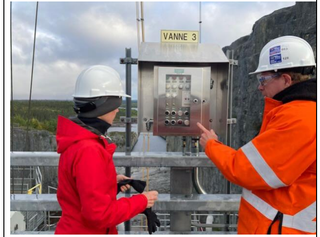
Photo 57 : Contrôle des vannes de l'évacuateur
