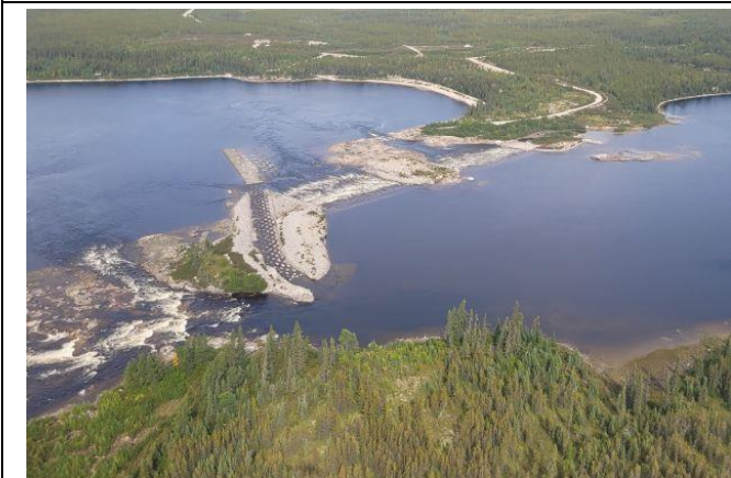
Photo 136 : Passe à poissons sur la rivière Rupert
