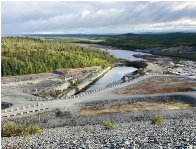
Photo 52 : Vue vers l'aval du barrage Bernard-Landry
