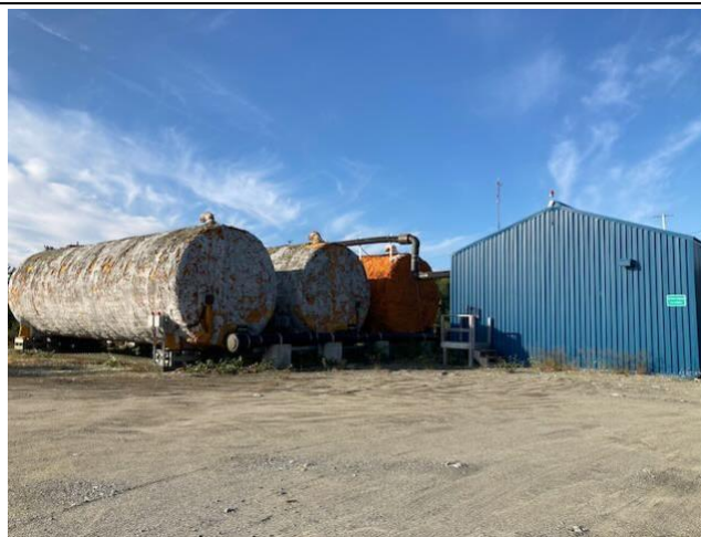
Photo 26 : Réservoirs d'eau douce isolés
