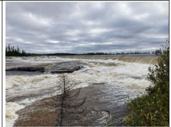
Photo 102 : Déversoir depuis l'aval
