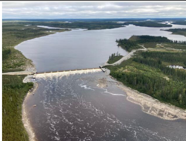
Photo 95 : Déversoir de la rivière Rupert avec frayères aménagées
