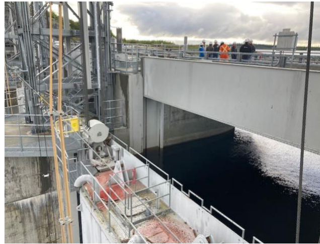
Photo 53 : Vannes de l'évacuateur du barrage Bernard-Landry
