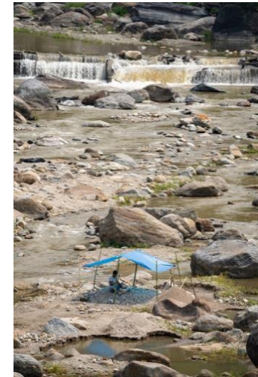
तस्विर ६०: पुवा एचपीपी नजिकैको खोलाको किनारमा निर्माण कार्यका लागि ग्राभेल उत्खनन गर्दै
