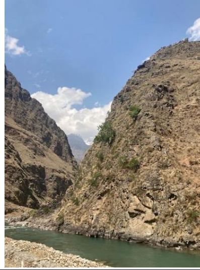
तस्विर ४४: कर्णाली राजमार्ग पुल निर्माण स्थलबाट चुवा खोंचको दृष्य, माथिल्लो भागमा स्वचालित पानी नाप्ने यन्त्र (Automatic Ater Level Recorder)
